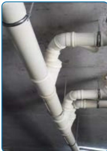
Les **systèmes d'évacuation insonorisée AR®** permettent l'installation de structures silencieuses pour des projets de construction. Le **PVC à trois couches** qui compose cette gamme présente des avantages uniques, notamment des niveaux sonores réduits et la meilleure protection contre le feu qu'un plastique puisse atteindre.
