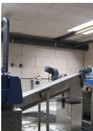
Convoyeur à vis sans âme
