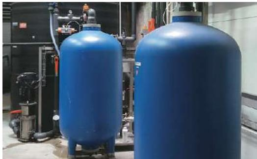
Service dédié à la production d'eau déminéralisée par le biais de cylindres de déminéralisation. Ils sont livrés, installés et contrôlés de façon à produire une eau déminéralisée de qualité.
