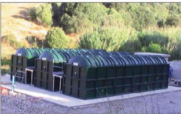
3 stations BLIVET 500 EH en parallèle et hors sol
