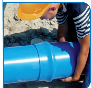
Exercer une poussée sur l'extrémité mâle pour l'introduire dans la tulipe jusqu'à la marque.
