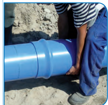
Aligner les tubes et introduire le chanfrein dans l'entrée de la tulipe.
