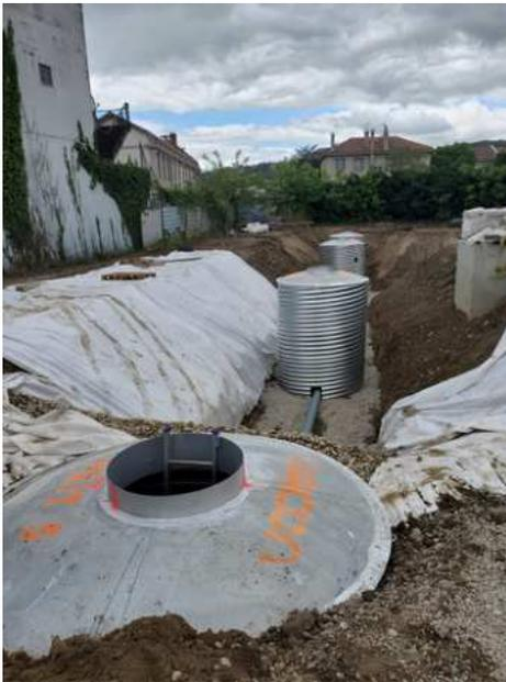
Puits en série : communication par drains
