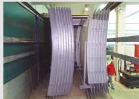
W-Tank® de H=11m, D=13.2m y 1.505 m³ de capacité transporté par camion.
