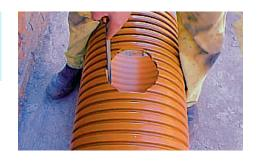
Introduire le clip élastomère en faisant correspondre les flèches du joint avec l'axe longitudinal du tube.
