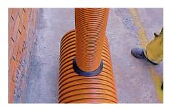
En option, avant d'insérer le tube, une butée en forme de diadème peut être placée pour empêcher le tube d'entrer plus que nécessaire vers l'intérieur du collecteur ou du regard.
