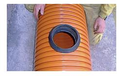
Introduire le branchement correspondant dans le clip en utilisant du lubrifiant pour faciliter la connexion.
