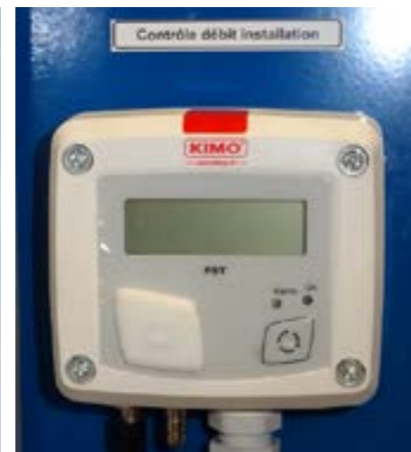
Contrôle débit d'installation
