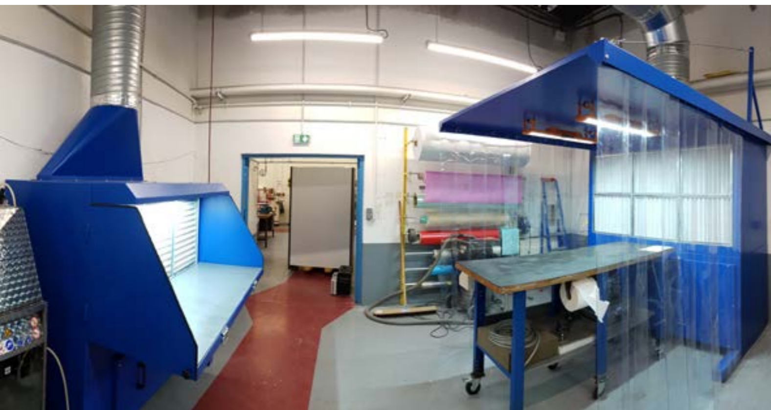
TP200 So + CA 200 So - Atelier de maintenance
