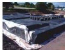
2006 - Bassin sous espace vert Cheddar (GB) - 3250m 2
