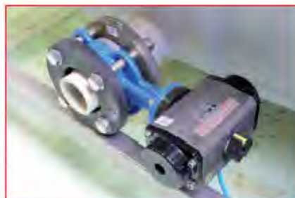
Purge de fond automatique
