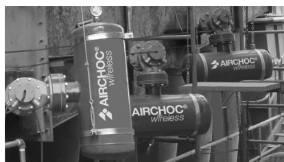
ÉLIMINATION DES COLMATAGES & CONCRÉTIONS
