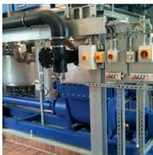
Convoyage de boue du décanteur au silo : KL65RÜ80.4 ESP avec contrôle du niveau de remplissage
