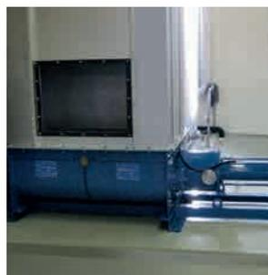
Convoyage de la boue d'épuration asséchée du décanteur vers le séchage : KL65R80.2 Pompe à vis excentrique Triplex
