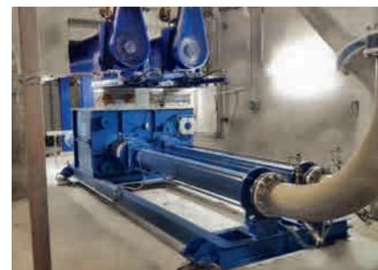
Convoyage de boues d'épuration asséchées : KL80RQ110.4+110.4 Pompe à vis excentrique
