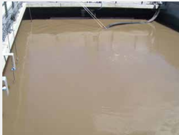
Étape 2 Alimentation et décantation
