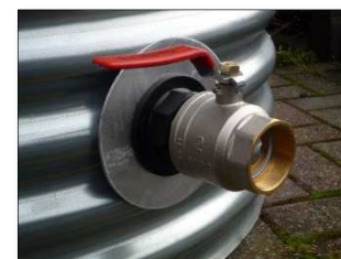
Traversée de cloison
