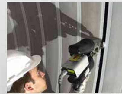
Soudure sur site
