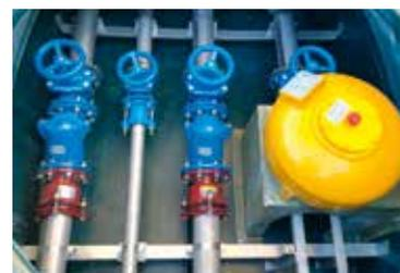
Ballon anti-bélier dans le regard pour protéger les systèmes de pompage et le réseau de refoulement
