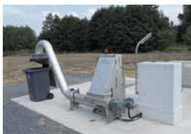
Station de pompage équipée d'un dégrilleur automatique
