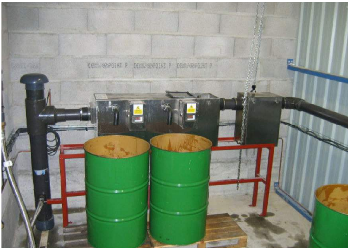
Système de récupération des graisses en petites quantités 100 litres par jour
