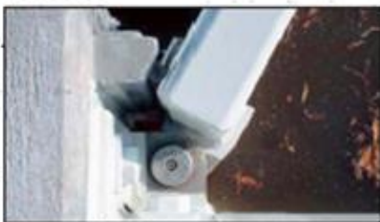
Connexion au mur de départ
