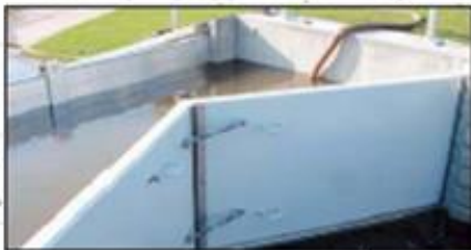
Test de fuite
