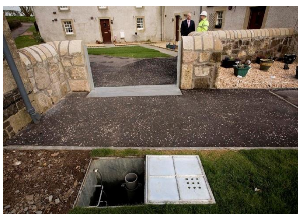
Fig 5. 2010: Freuchie Mill, Ecosse - position basse, montrant la fosse de service
