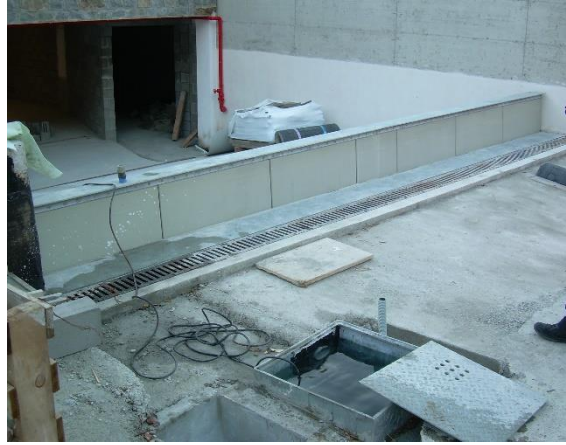
Fig 10. 2012: Italie. Protection d'un parking souterrain.
