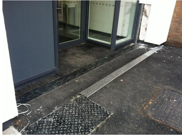
Fig 8. 2012: Turks Boatyard, Londres. Protection d'un accès piéton de parking souterrain.
