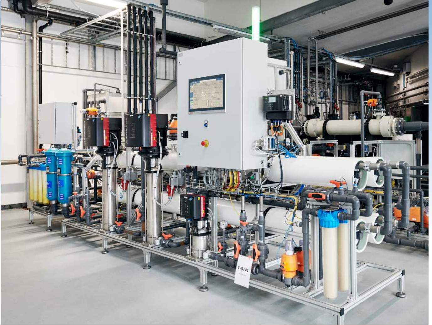
Ce système traite les eaux usées issues du traitement de surface CED Grundfos avec une série de filtres et une unité d'osmose inverse. Il renvoie ensuite l'eau nettoyée vers l'unité CED en vue de sa réutilisation.
