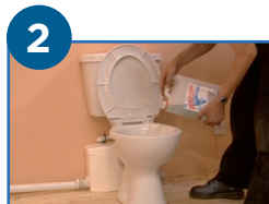
2 Mettre dans la cuvette une dose de détartrant.
