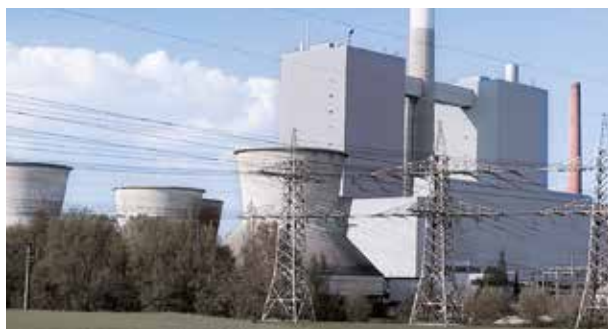
Indispensable dans les centrales électriques
