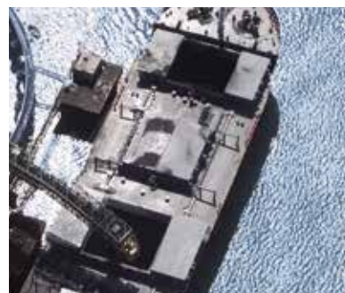
Performant pour le chargement et le déchargement de bateaux.
