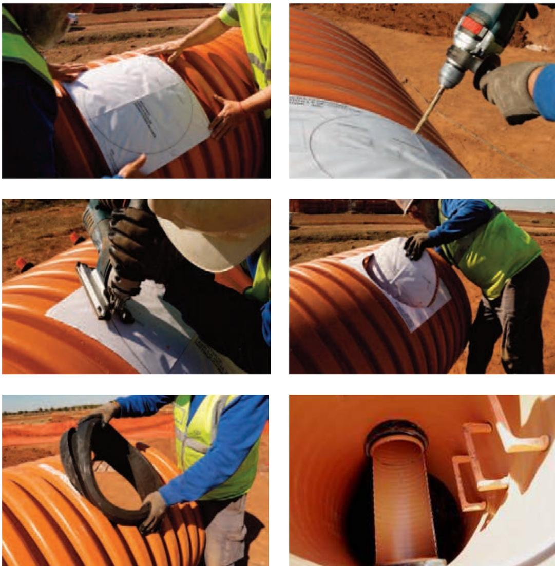
Séquence de l'installation d'un clip élastomère
