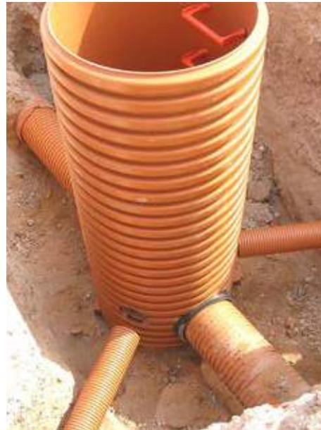
Le corps du puits SANECOR® est fabriqué à partir de tuyauterie SANECOR® SN8
