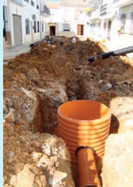
**Sécurité sur le chantier :** Il est connu de tous que la zone des regards est un point critique du chantier, du point de vue de la sécurité pour les travailleurs. Dans de nombreux cas, on arrête l'étalement et ce sont des zones de danger de glissements de terrain.
