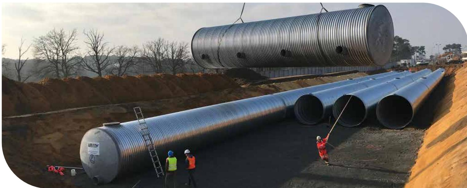
**Un bassin d'orage est un ouvrage qui retient et régule les eaux pluviales produites lors d'un orage.**
