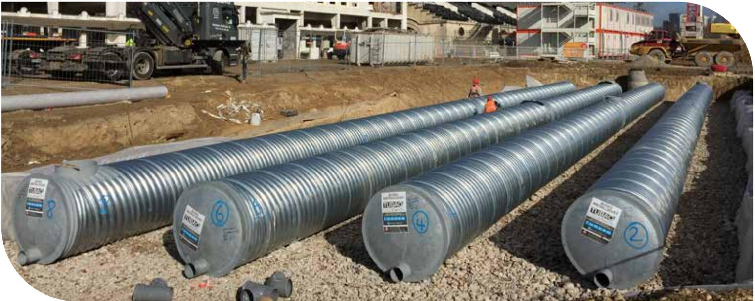
**Un bassin / puits d'infiltration visitable est un ouvrage qui retient les eaux pluviales issues d'un orage et les infiltre directement dans le sol, sans encombrer les réseaux.**
