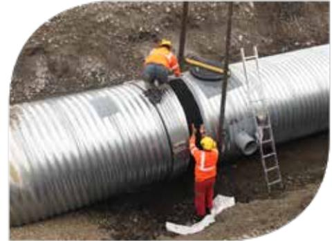
Les colliers servent au raccordement des TUBAO®. Ils sont en acier galvanisé, ajustés au diamètre du tuyau. Ils peuvent être composés de plusieurs pièces à assembler selon le diamètre des tuyaux.
