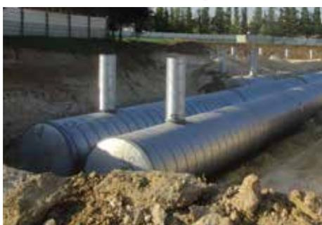
livrée en option sur demande et permet de faciliter l'accès à la cuve. Un couvercle en acier est fixé sur la rehausse à l'aide de boulons. Il n'est pas prévu pour supporter le passage de véhicules.
