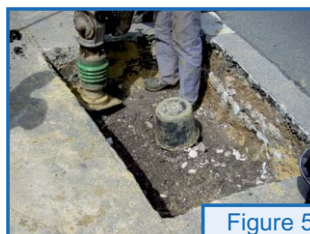
Figure 5 Compactage du matériau de remplissage.
