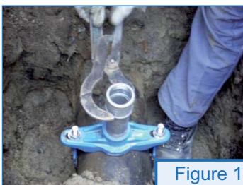
Figure 1 Préparation de la connexion. Ici: Raccordement par collier de prise en charge 2".
