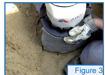
Figure 3 Mise en place de la garniture de protection.
