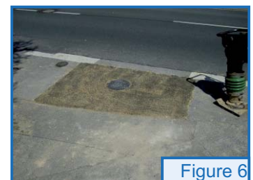
Figure 6 Finition de la chaussée.
