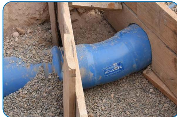
**15** Il est recommandé d'utiliser des joints en EPDM, néoprène,... entre le tuyau et le béton qui apportent une certaine protection à l'accessoire face aux efforts coupants, à cause de la traction du béton du bloc d'ancrage.
