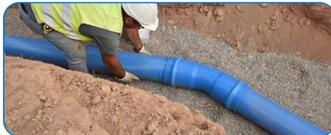
**7** Avant l'installation, **il faudra tenir compte des dimensions du bloc de béton d'ancrage**, en ayant préparé la géométrie de la tranchée de manière adéquate pour son exécution postérieure. De cette manière, on évitera d'endommager l'accessoire une fois installé.
