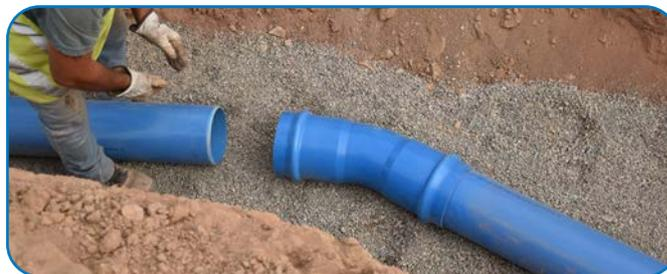
**6** Durant l'assemblage, il convient d'**éviter les coups sur l'accessoire**, surtout sur la crête des emboîtures d'union, recommandant l'installation manuelle de celui-ci, si possible ou en utilisant des sangles en toile.
