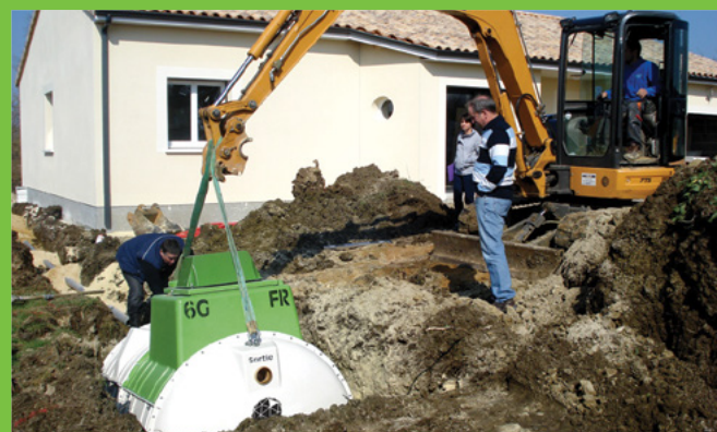
Installation d'une Tricel Novo FR6
