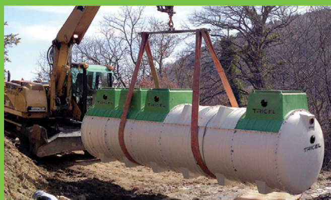
Installation d'une Tricel Novo FR20
