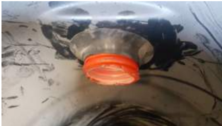
Fig-27 : placement de la gaine de protection
