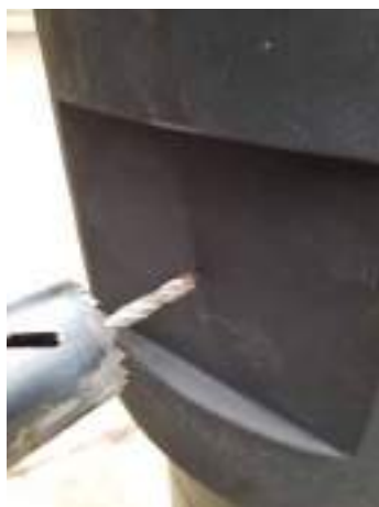
Fig-20a : placement de la gaine de protection attention percez à la scie cloche Ø67
