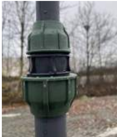
Fig-21 : réduction PP à serrer Ø 40/32 mm
