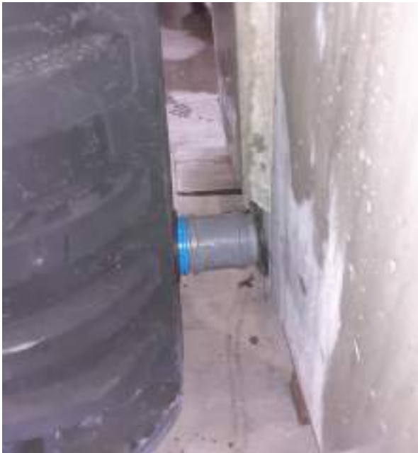
Fig-7 : raccordement du relevage au filtre compact x-perco® C-90 5EH
