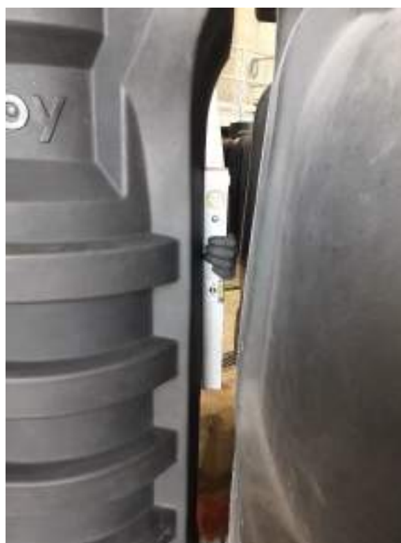
Fig-11 : vérification de l'aplomb après fixation à un filtre compact x-perco® R-90 monobloc
