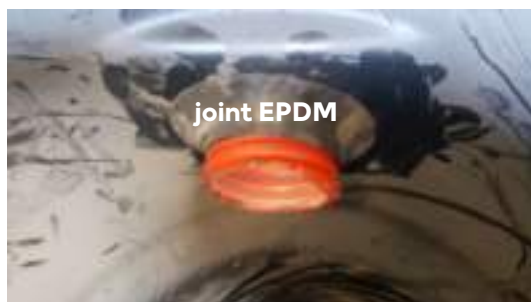
Fig-20b : placement de la gaine de protection attention installez le joint EPDM Ø63 (sans graisse)
