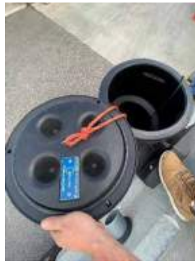
Fig-22b : corde à l'extrémité de l'œillet du tampon
