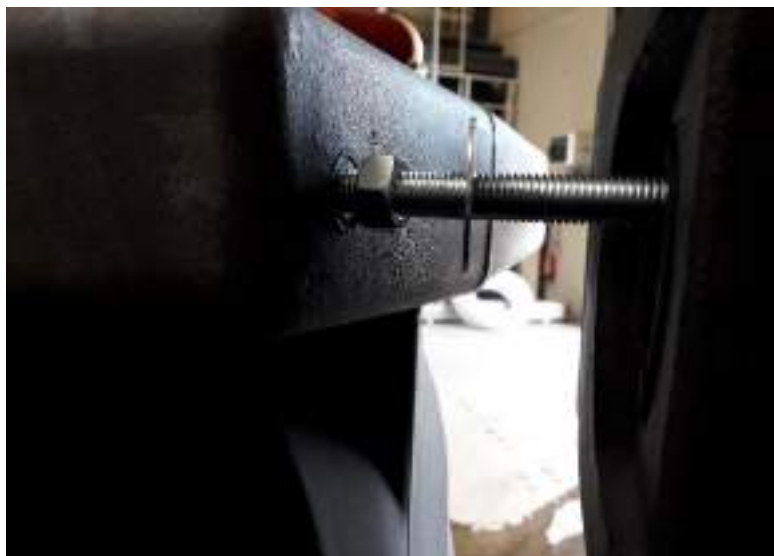
Fig-10 : fixation à un filtre compact x-perco® R-90 monobloc
