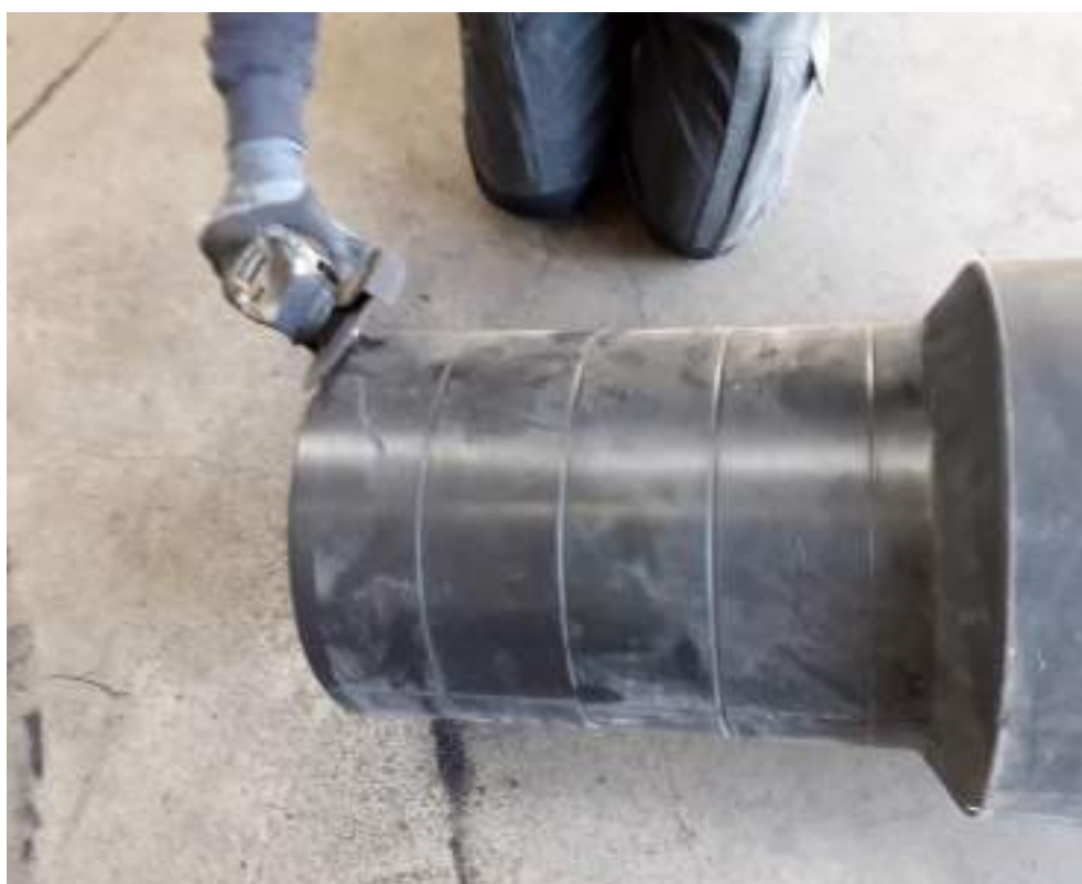
Fig-16 : chanfreinage de la rehausse coupée
