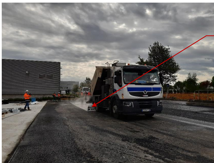
FIGURE 8 : EPANDAGE DE L'EMULSION D'ACCROCHAGE
