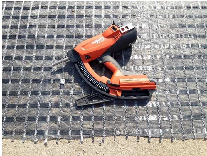
FIGURE 13 : PISTOLET A SPITS ET SPIT INSTALLE
