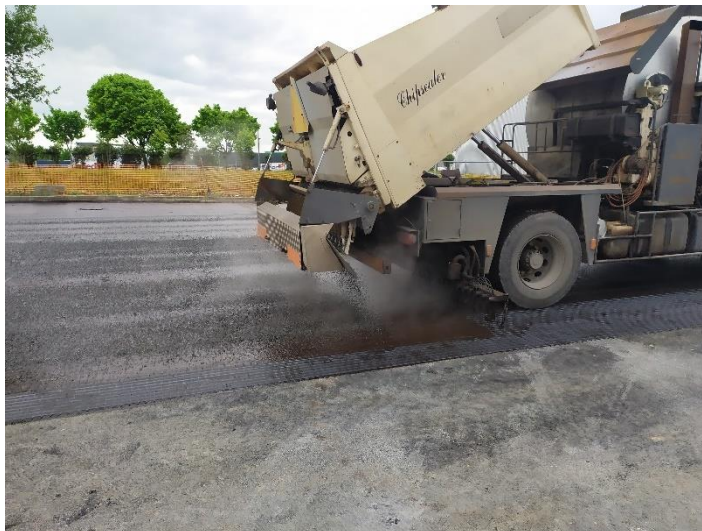
FIGURE 17 : GRAVILLONNAGE SUR LA GEOGRILLE
