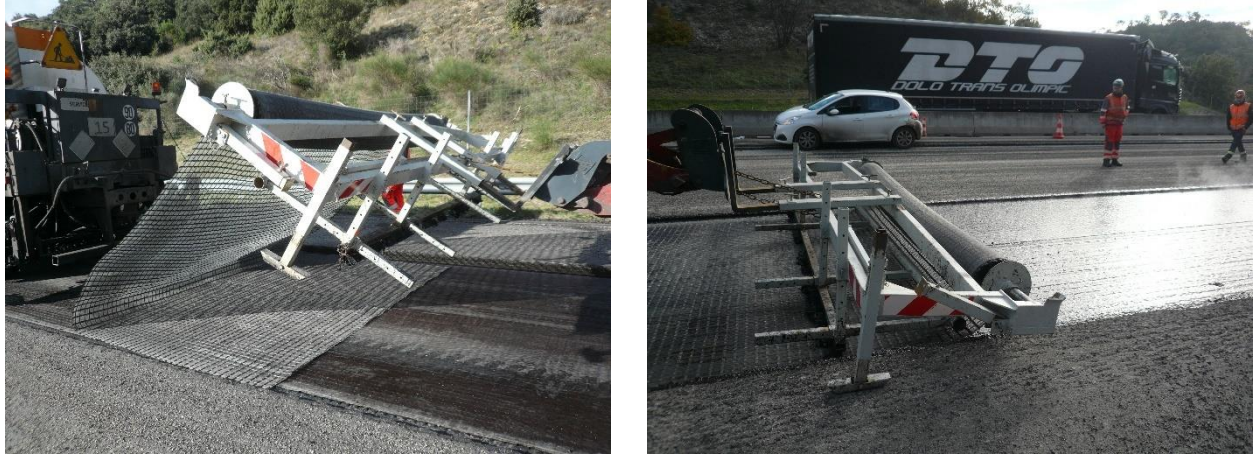
FIGURE 12 : DEROULEUR DE GEOGRILLE EN ACTION
