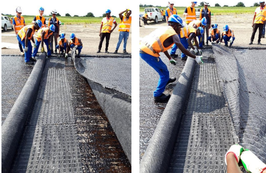
FIGURE 16 : RECOUVREMENT SENS LONGITUDINAL
