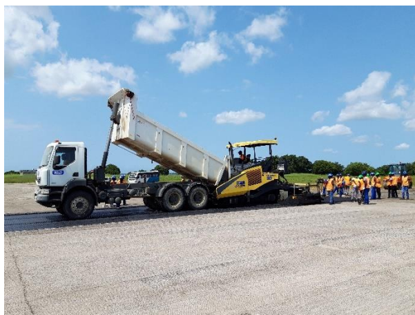
FIGURE 18 : PASSAGE DU FINISHER
