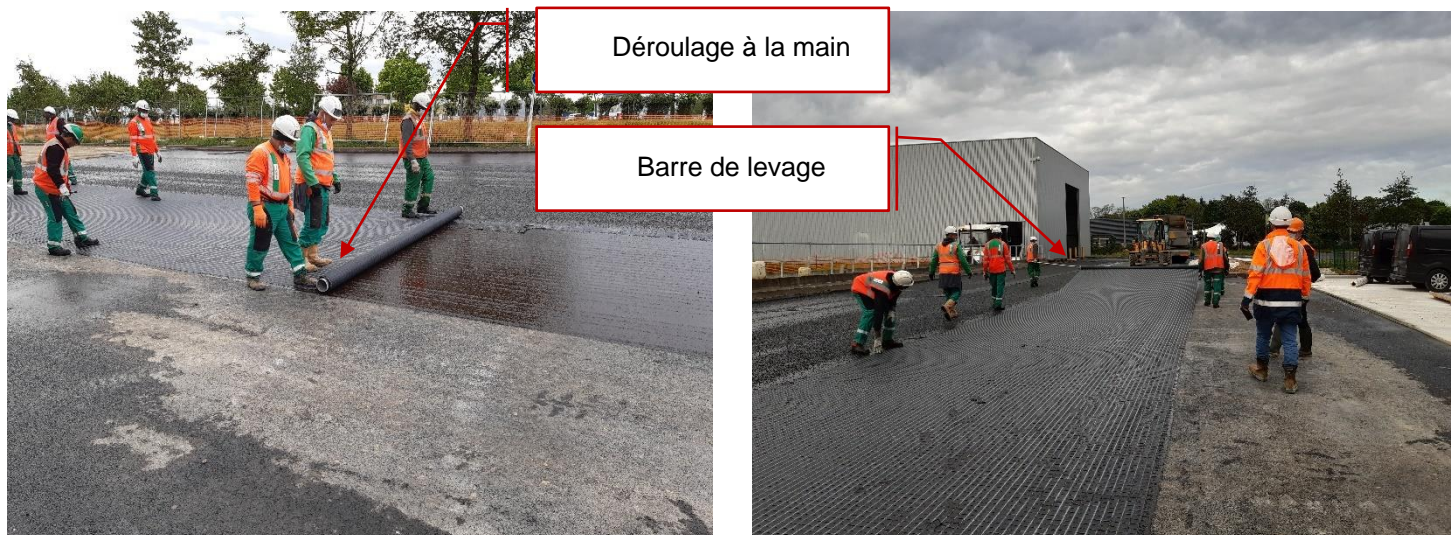
FIGURE 10 : DEROULAGE A L'AVANCEMENT AVEC ET SANS BARRE
