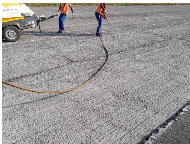
FIGURE 7 : NETTOYAGE DU SUPPORT PAR SOUFFLEUR
