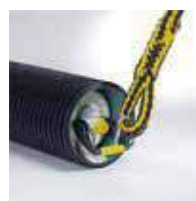
4. Mise en place de la corde
