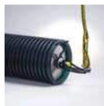
4. Mise en place de la corde
